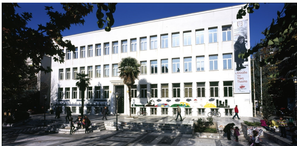
Τμήμα Ιατρικής Πανεπιστημίου Θεσσαλίας (Κτίριο Κατοίγρα)
